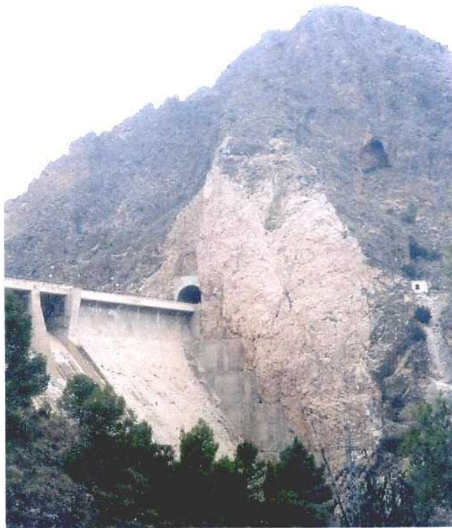
Fotografía 4.3. Coloración más clara de la zona saneada para la construcción del estribo izquierdo de la presa del Cenajo, en la cabecera del Río Segura.
